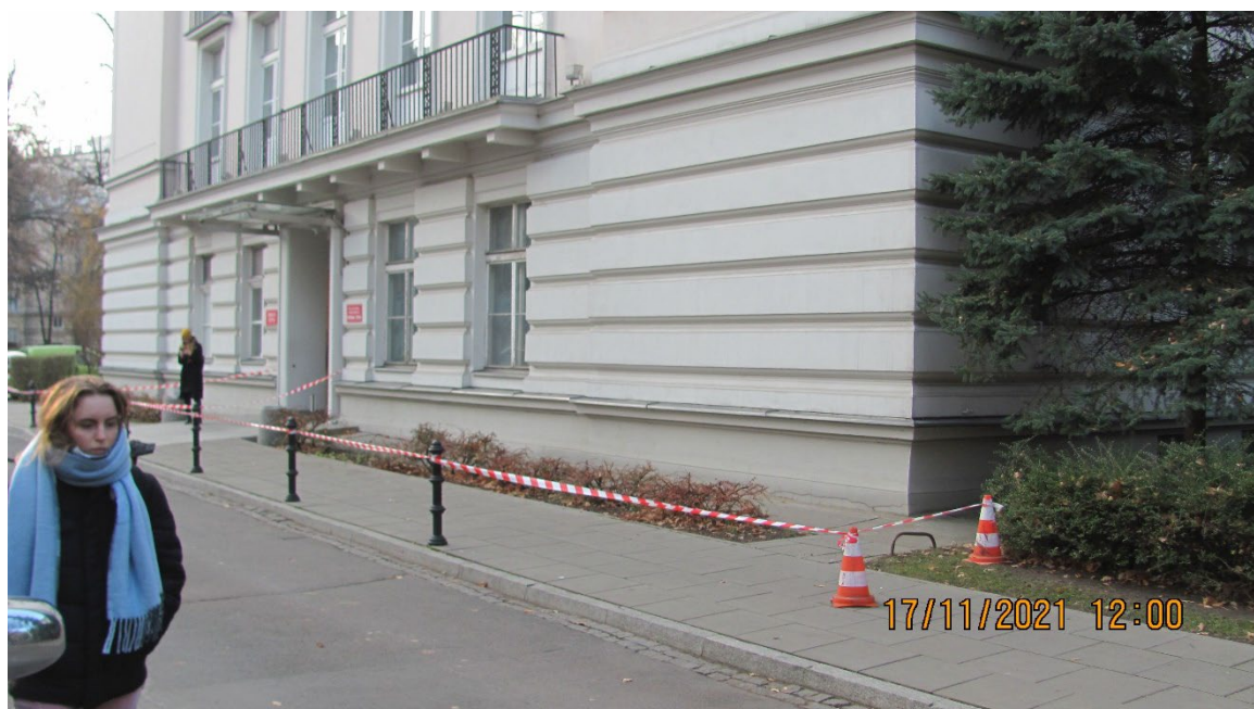
Zdj.1 Dojście piesze z widokiem na narożnik budynku
